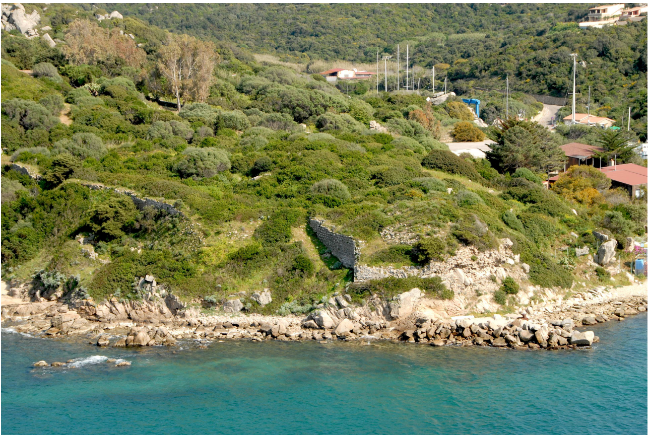
Foto ruderi della cinta muraria del Castello. Foto di Paolo Molino
