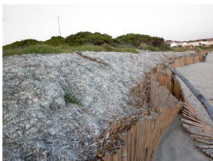
Fig. 5 – Particolare accumuli artificiali di sabbie e fogliame di Posidonia sottratte dalla berma (foto da W verso E)
